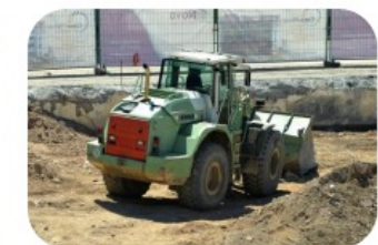
Uso de maquinaria o vehículos de bajo nivel sonoro
